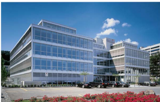
Die moderne Glas-Metallfassade OC Oerlikon und LGT – eines der zahlreichen renommierten Projekte der Kälin + Hiestand AG.
