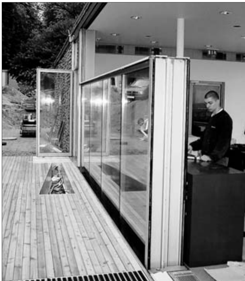
Komplett und halb geöffnete Senkfront auf dem Schlossberg in Graz. (zvg)
